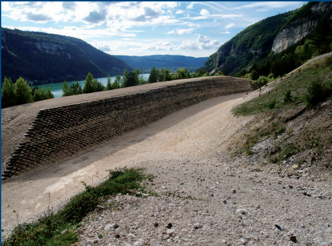
Merlon pare-bloc de Nantua (01) réalisé avec TenCate Rock® et TenCate Miragrid GX.
