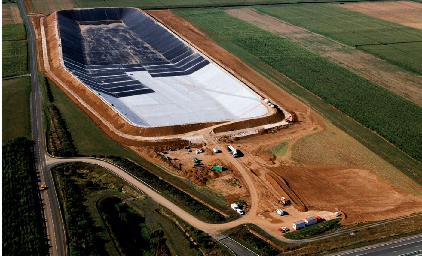
Vue d'ensemble du bassin d'irrigation de Saint-Pierre-le-Vieux (85), réalisé à l'aide de la gamme TenCate Bidim® P.
