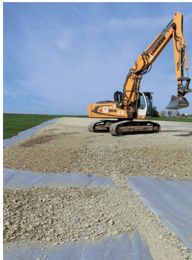
Terrassement à l'aide d'un géotextile de séparation TenCate Bidim® S.
